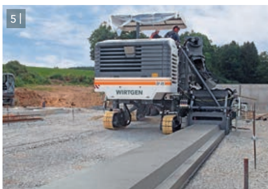
6 | Getto in opera di un profilo speciale per un'azienda agricola.
