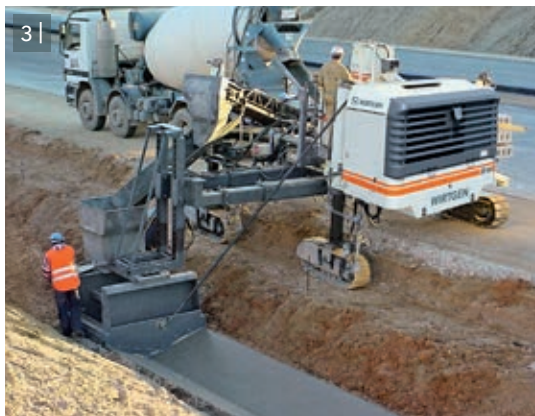
3 | Getto in opera di una cunetta di scolo delle acque piovane dal lato sinistro della macchina.
